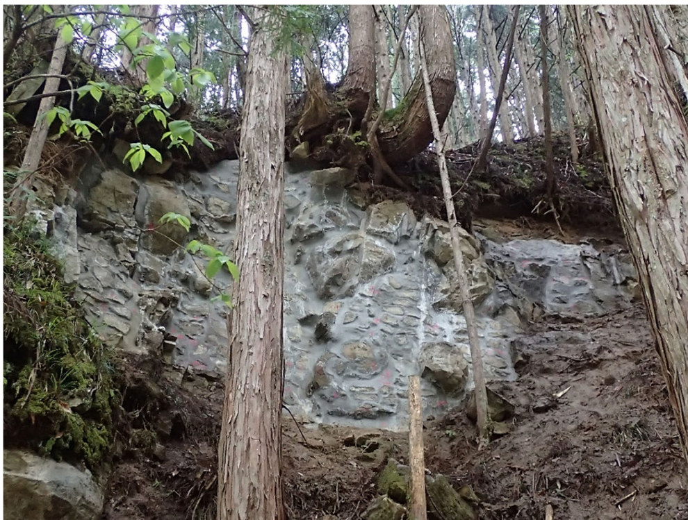
2016 年度施工 奈良県天川村洞川地内
