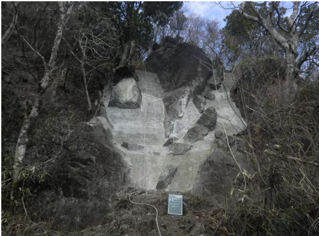
施工後(着色前)
