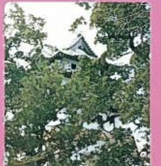
④ 洲本市・洲本城の瓦落下
